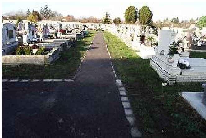
A temető felújítása során aszfaltburkolatú járdák lettek kiépítve.
